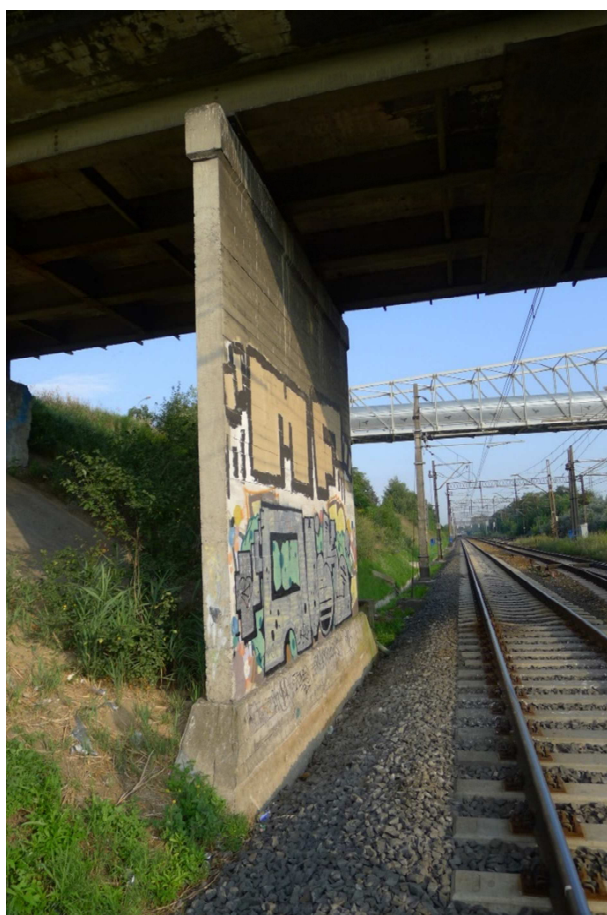
Fot. 30. Widok na podporę nr 2.
