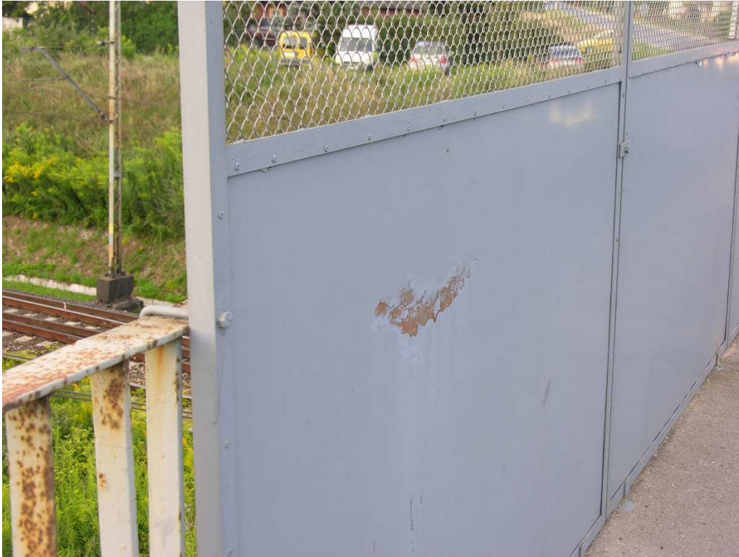
Fot. 39. Niewielki ubytek powłoki malarskiej.
