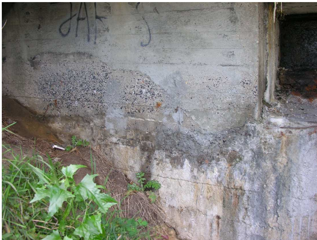
Fot. 36. Znaczna erozja betonu. Brak spoiwa cementowego na powierzchniach licowych. Wystające skorodowane zbrojenie.
