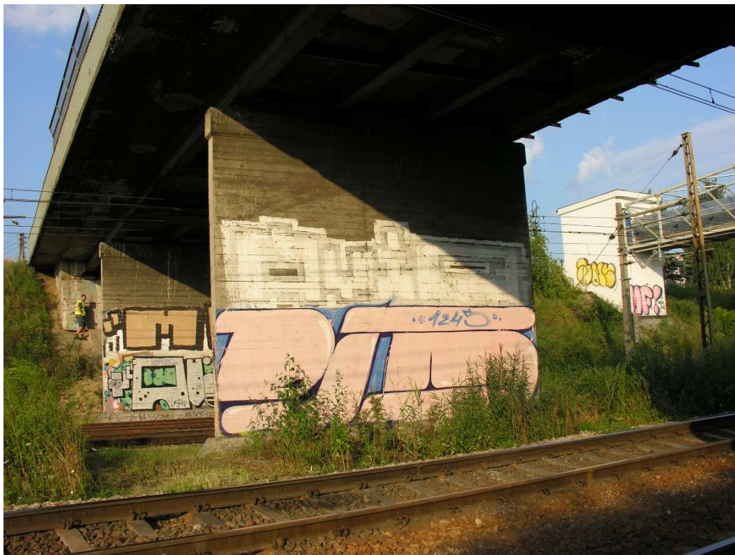
Fot. 31. Widok na podporę nr 3.
