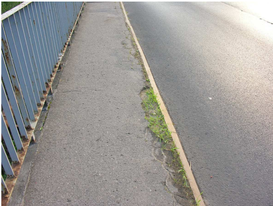
Fot. 5. Ubytki nawierzchni chodnika. Wegetacja roślinna
