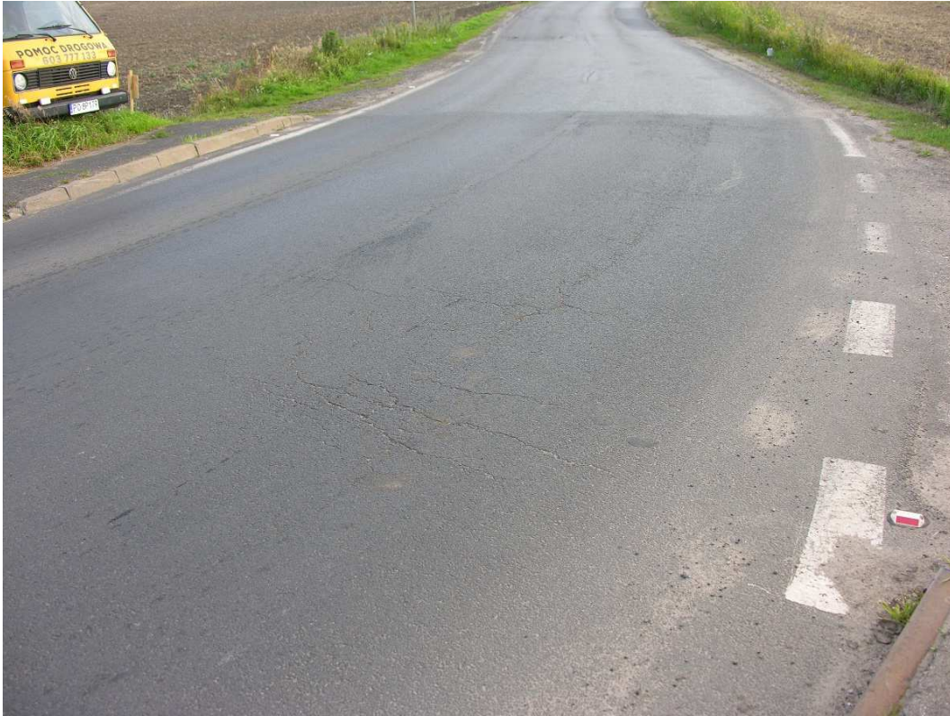
Fot. 3. Pęknięcia na nawierzchni na dojeździe od strony ul. Obodrzyckiej. Zniszczony krawężnik.
