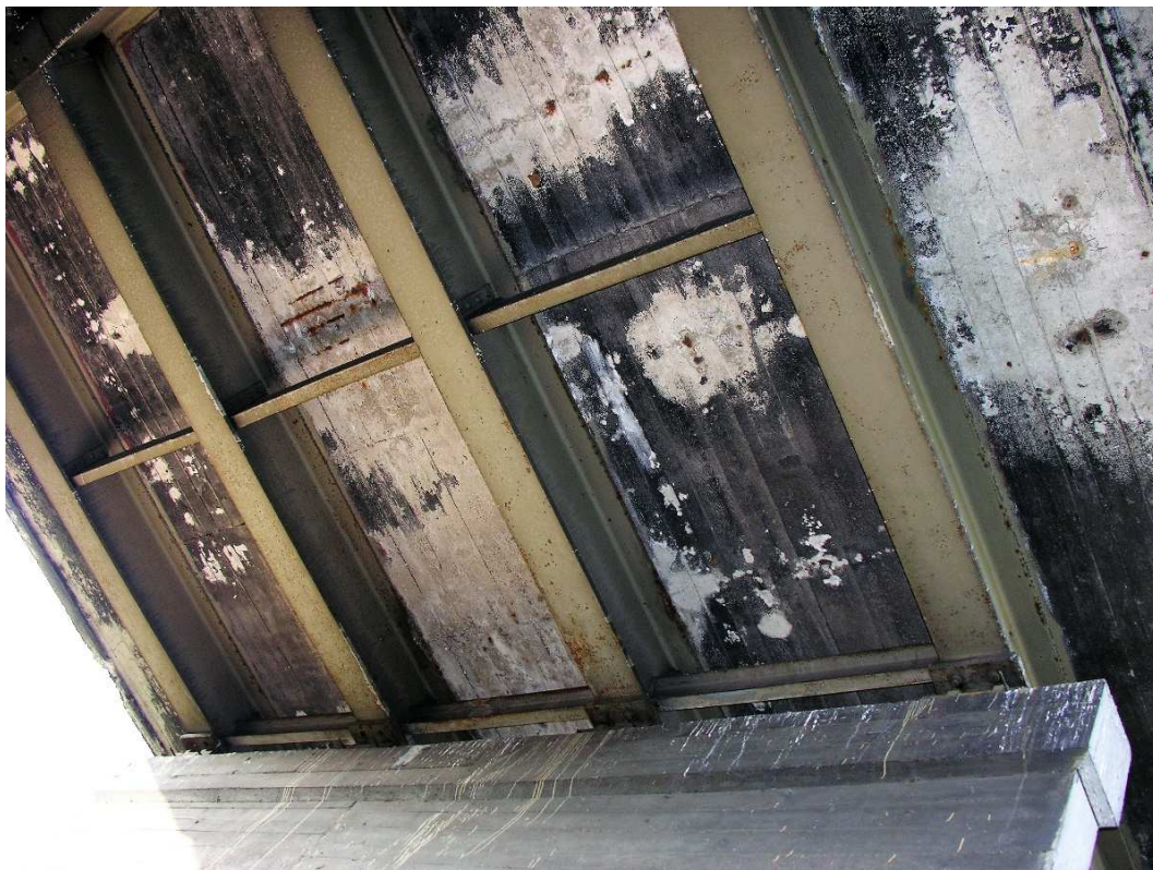
Fot. 11. Drobne ogniska korozji na konstrukcji stalowej. Nacieki spowodowane przesączaniem się wody. Zabrudzenia pochodzące od spalin taboru. Rdzawe nacieki na płycie pomostu. Odslonięte zbrojenie.
