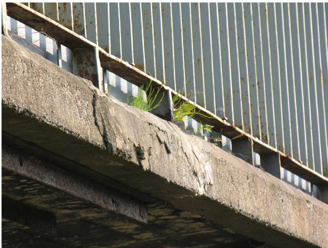
Fot. 23. Mocno skarbonizowany fragment gzymsu. Niedbała naprawa.
