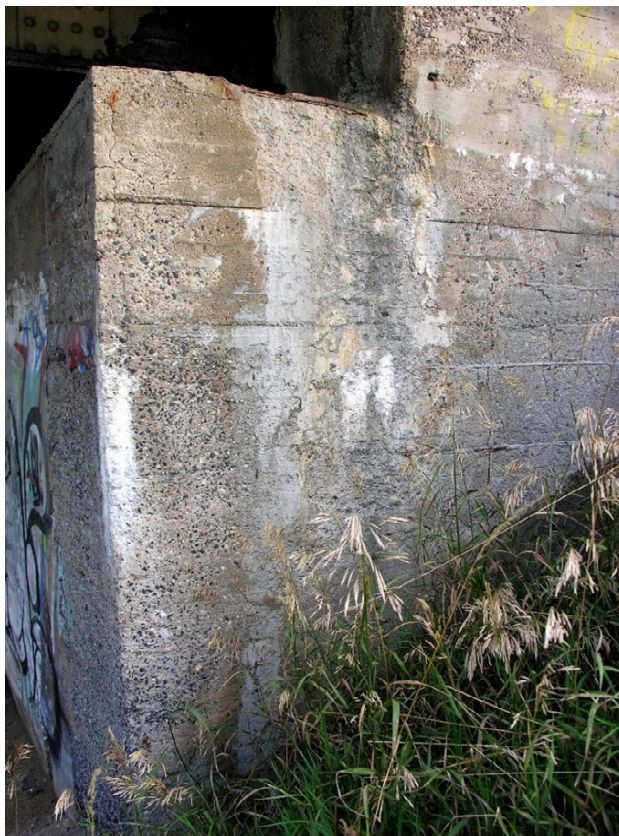
Fot. 35. Znaczna erozja betonu. Brak spoiwa cementowego na powierzchniach licowych. Wystające skorodowane zbrojenie.
