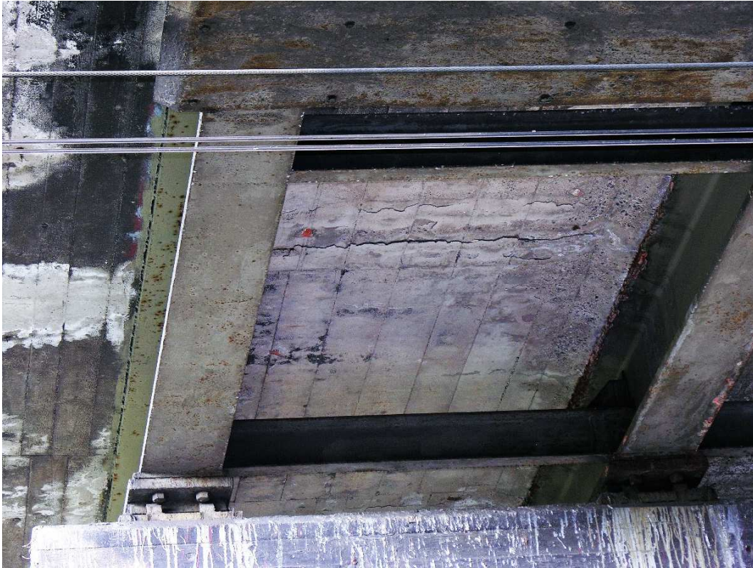
Fot. 13. Pęknięcie poprzeczne płyty pomostowej. Drobne ogniska korozji na konstrukcji stalowej.
