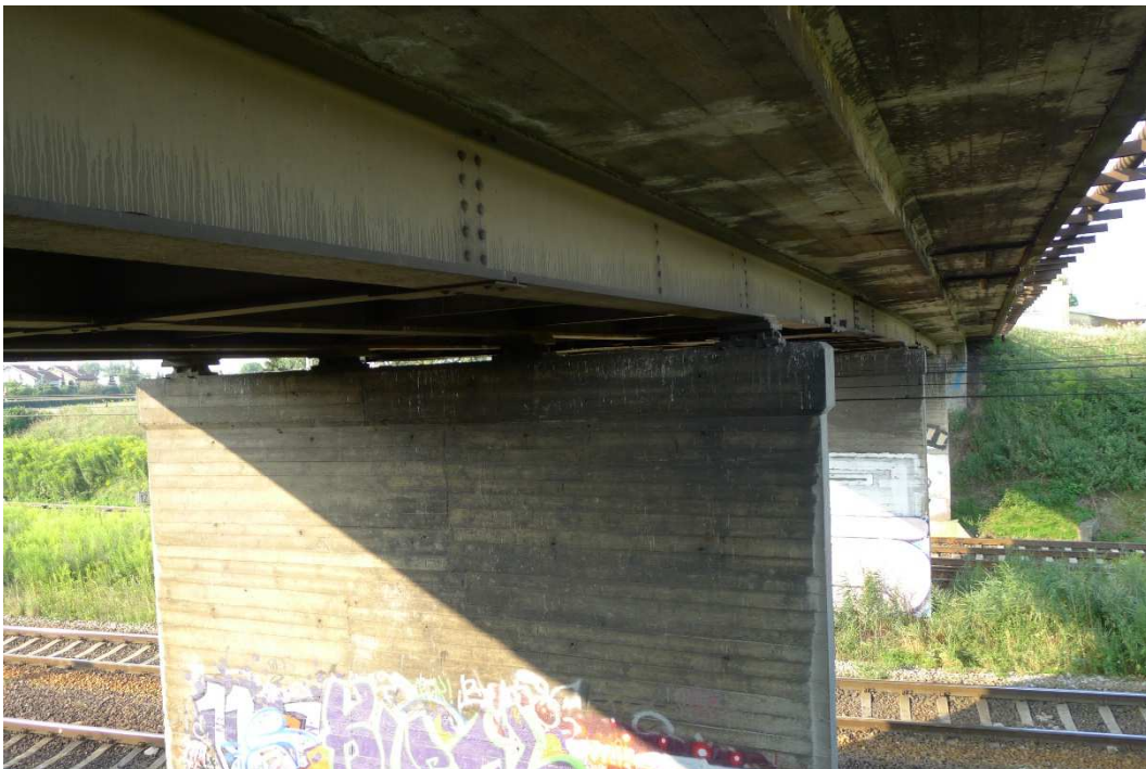
Fot. 18. Poprzeczne pęknięcia wspornika. Nacieki z węglanu wapnia wzdłuż pęknięć.
