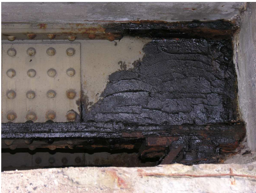
Fot. 16. Korozja dźwigara przy dylatacji przy podporze nr 5. Zabezpieczenie antykorozyjne smarem. Korozja łożyska.
