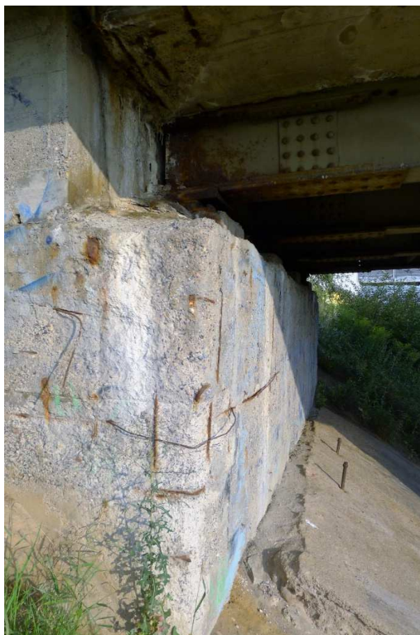
Fot. 26. Znaczna erozja betonu. Duże ubytki. Brak spoiwa cementowego na powierzchniach licowych – widoczne kruszywo i skorodowane zbrojenie.
