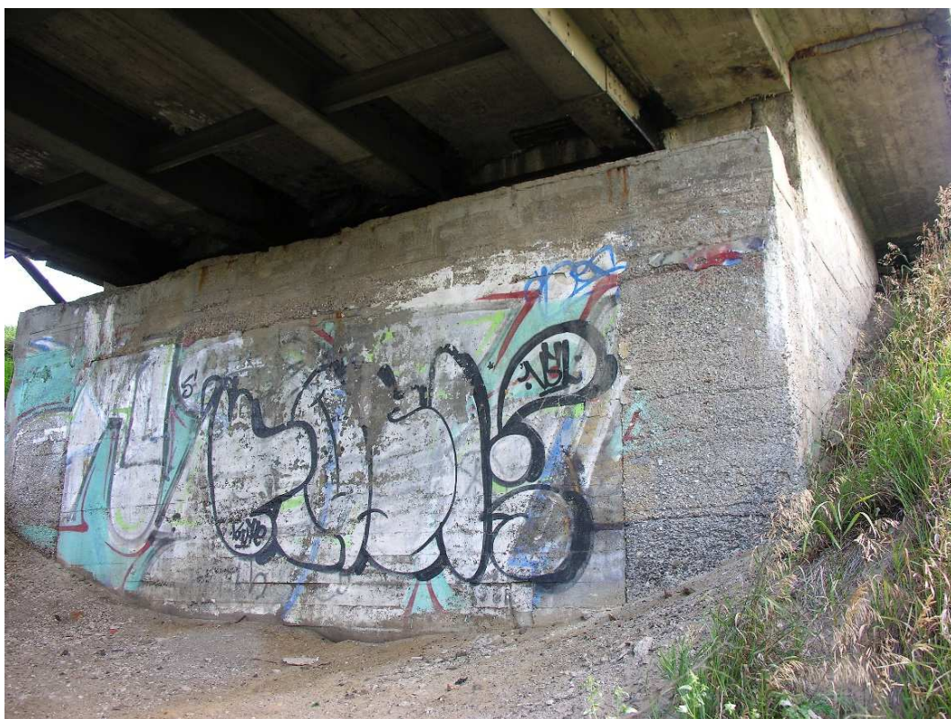
Fot. 34. Widok na podporę nr 5. Widoczny zakres nadbudowy przyczółka. Znaczna erozja betonu. Brak spoiwa cementowego na powierzchniach licowych.
