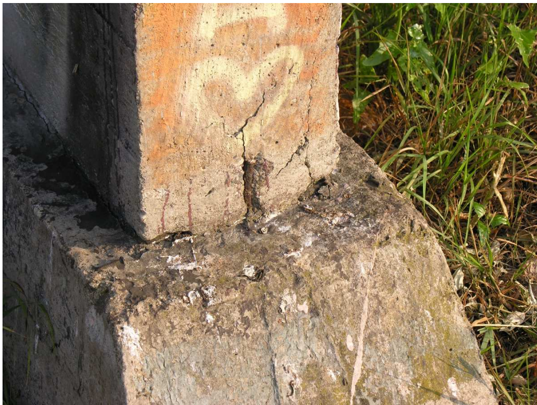
Fot. 33. Pęknięcie w przegubie podpory nr 3.
