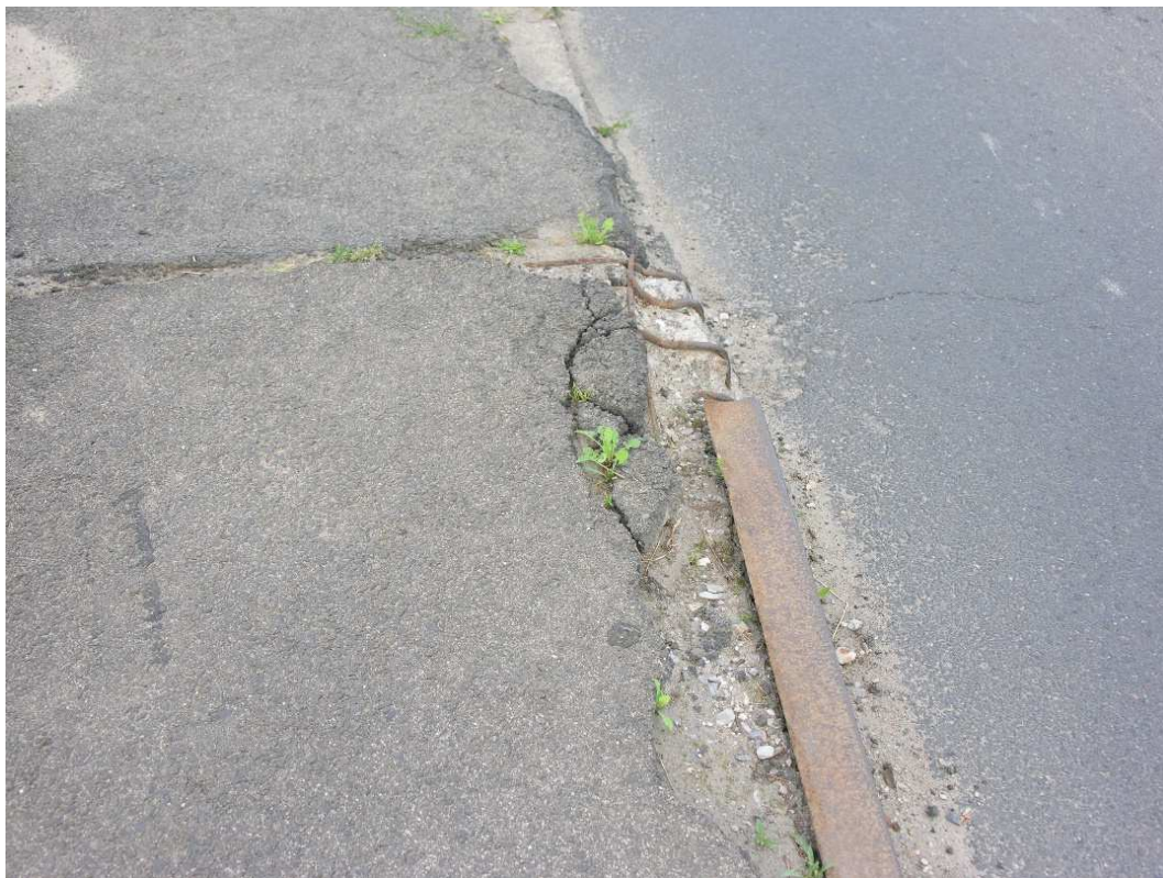
Fot. 29. Ubytek betonu na wewnętrznej krawędzi wspornika podchodnikowego.
