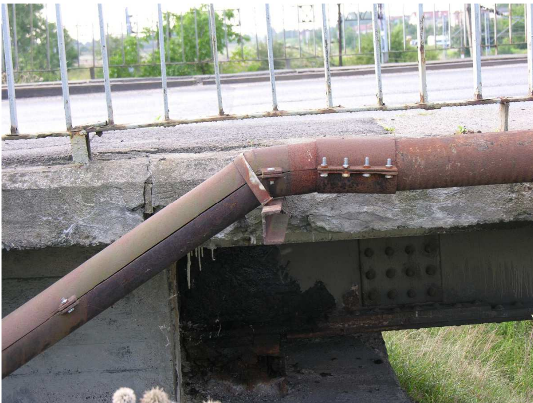
Fot. 40. Korozja rury osłonowej i wsporników.
