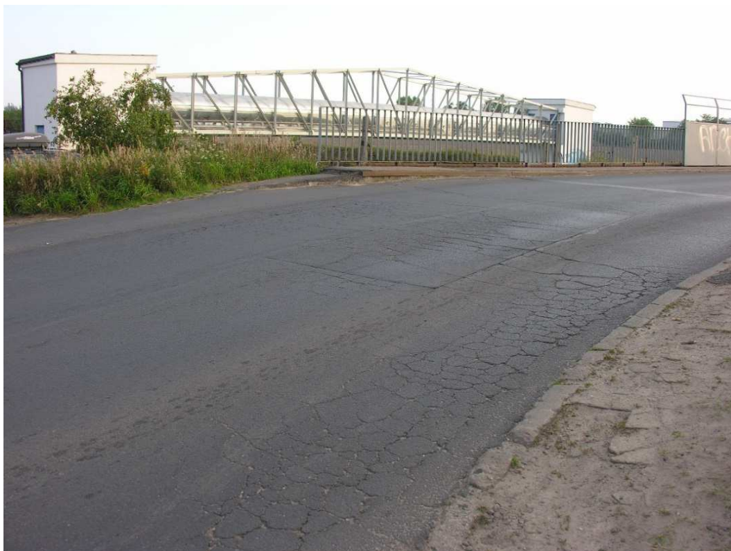
Fot. 2. Pęknięcia na nawierzchni na dojeździe od strony ul. Baranowskiej. Zniszczone krawężniki i porośnięte pobocza.
