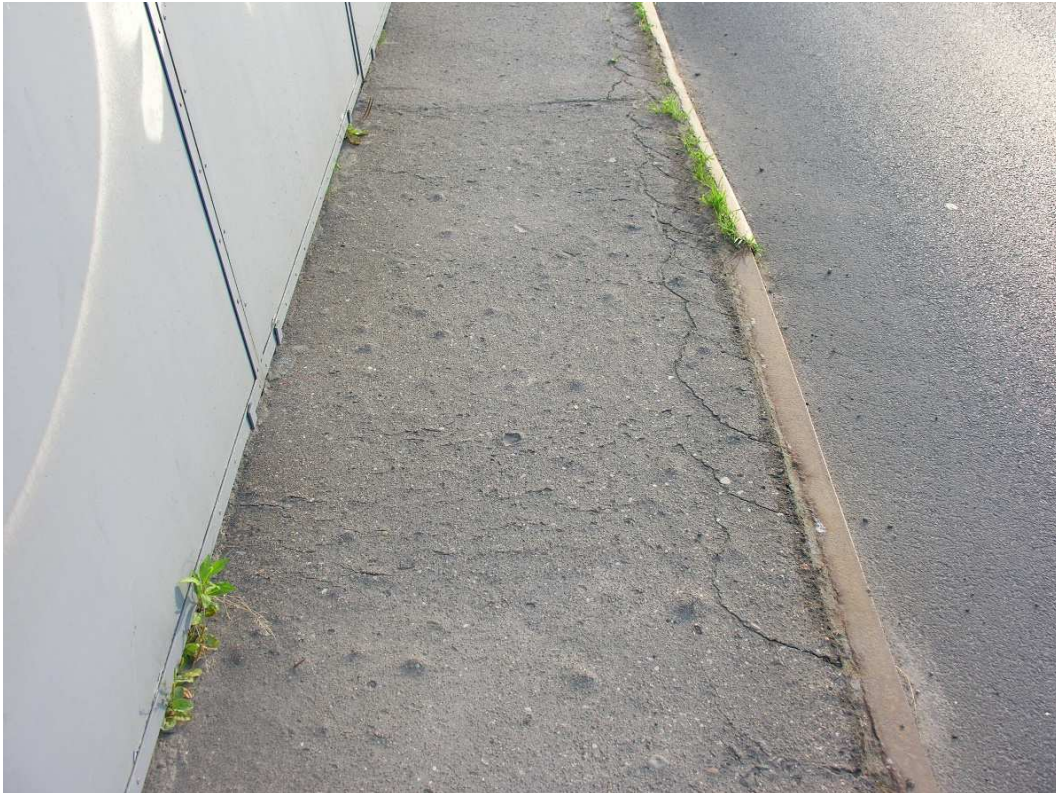
Fot. 4. Pęcherze na nawierzchni.
