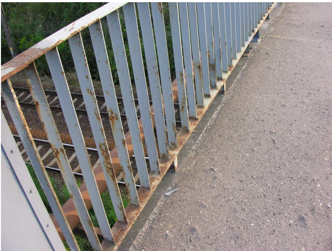
Fot. 38. Korozja elementów balustrady.
