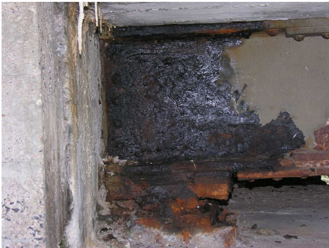
Fot. 15. Korozja dźwigara przy dylatacji przy podporze nr 1. Zabezpieczenie antykorozyjne smarem. Korozja łożyska.
