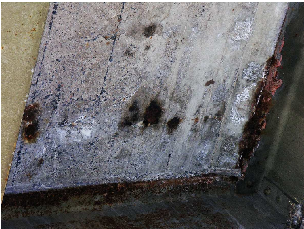
Fot. 12. Korozja na styku płyty pomostowej i dźwigara. Rdzawe nacieki na płycie pomostowej.
