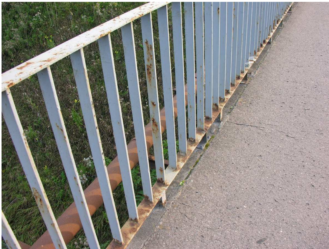
Fot. 7. Mech w szczelinie pomiędzy gzymsem i nawierzchnią. Pęknięcie poprzeczne.
