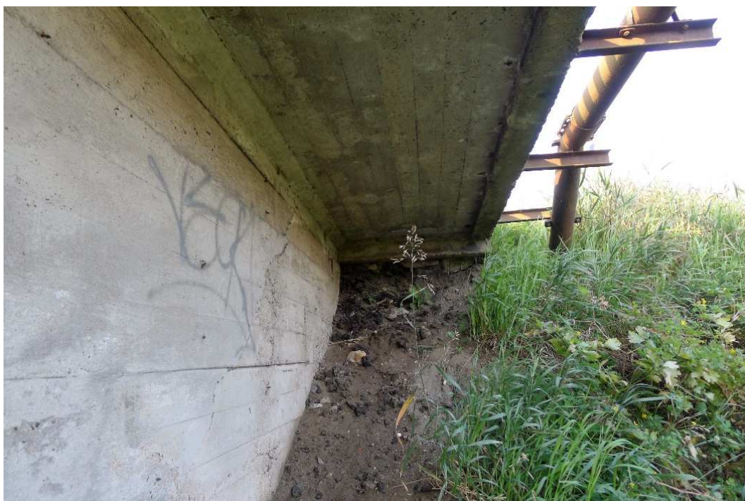
Fot. 28. Lokalne braki spoiwa cementowego. Pęknięcie ukośne skrzydła.
