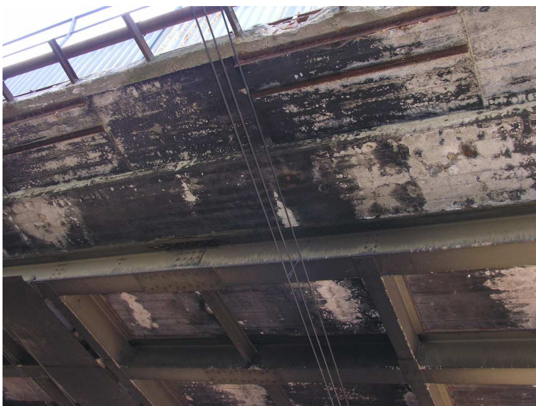
Fot. 24. Duży ubytek betonu na gzymsie w przęśle 5-6. Odślonięte kotwienie balustrady.
