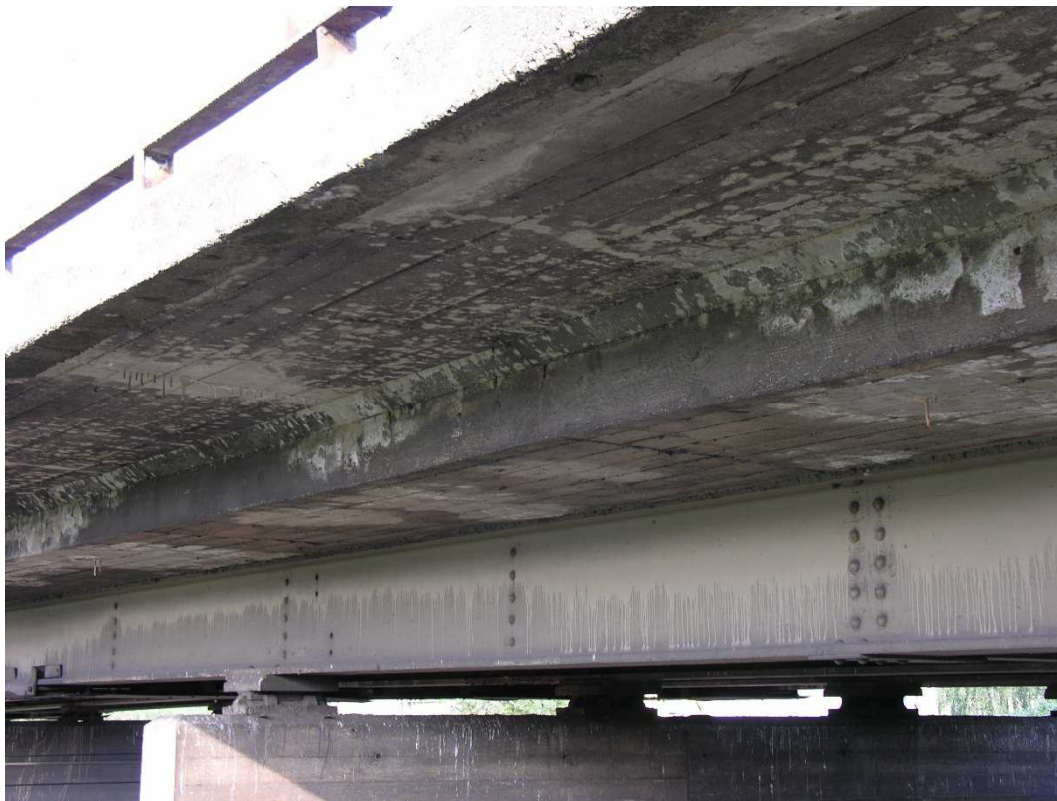
Fot. 19. Poprzeczne pęknięcia wspornika. Nacieki z węglanu wapnia wzdłuż pęknięć.
