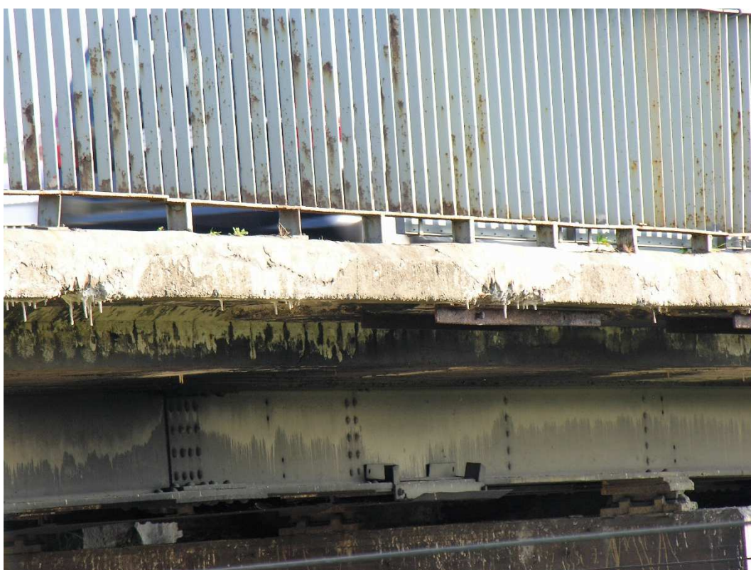
Fot. 22. Ubytki betonu na południowo – wschodnim gzymsie. Nacieki z węglanu wapnia. Nie- dbała naprawa.
