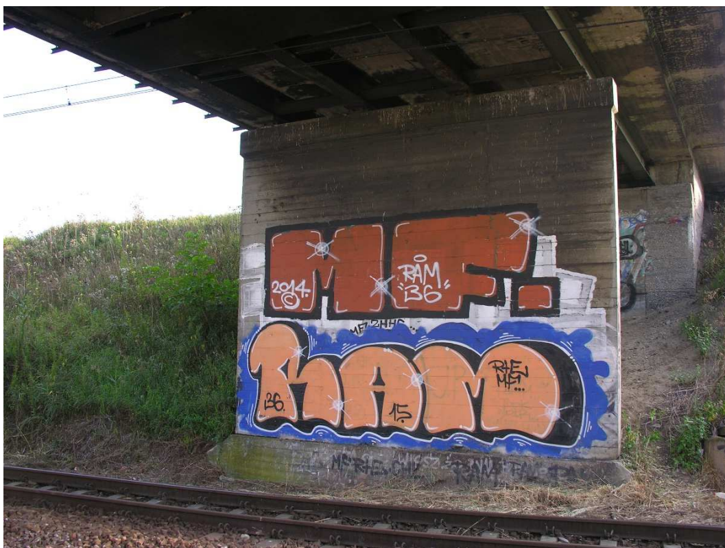
Fot. 32. Widok na podporę nr 4.
