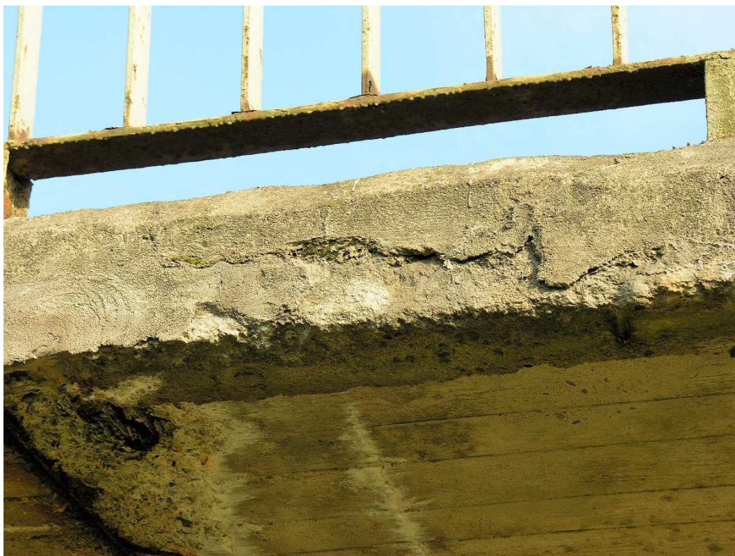
Fot. 21. Ubytki betonu na gzymsie przy dylatacji podpory nr 1.
