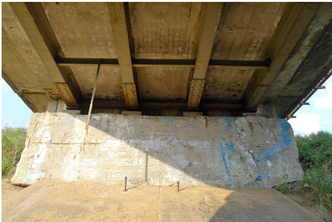
Fot. 25. Widok na przyczółek nr 1.
