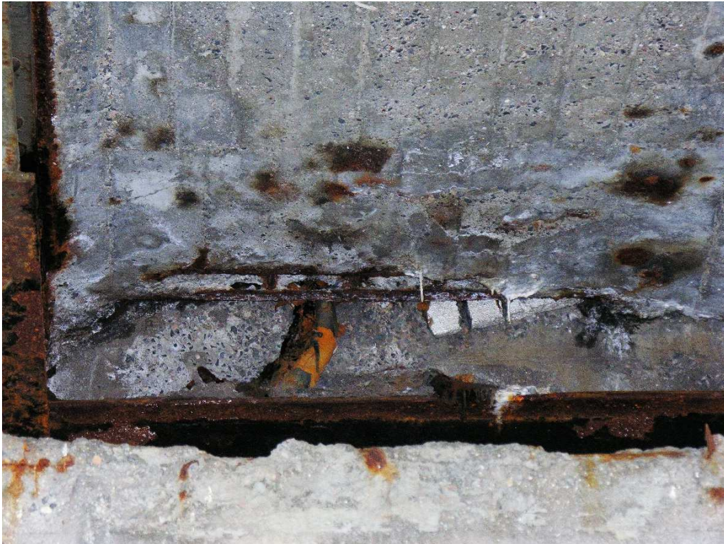
Fot. 14. Korozja poprzecznic podporowej.
