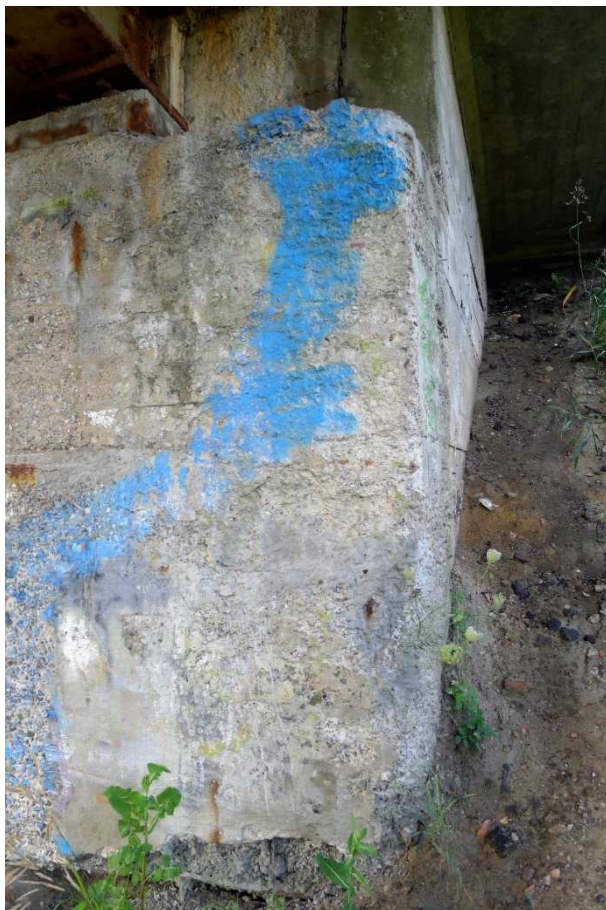
Fot. 27. Znaczna erozja betonu. Duże ubytki. Brak spoiwa cementowego na powierzchniach licowych – widoczne kruszywo i skorodowane zbrojenie
