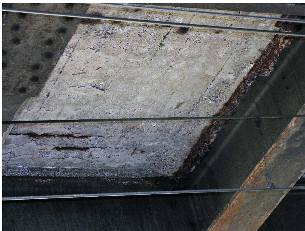
Fot. 10. Korozja na styku dźwigara i płyty pomostowej. Łuszczenie się otuliny. Wystające skorodowane zbrojenie.
