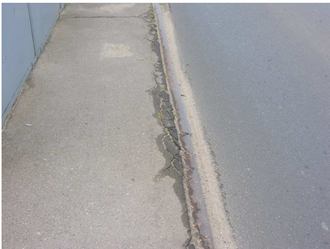
Fot. 6. Pęknięcia nawierzchni przy kątowniku zabezpieczającym krawędź wspornika. Pęknięcia poprzeczne.
