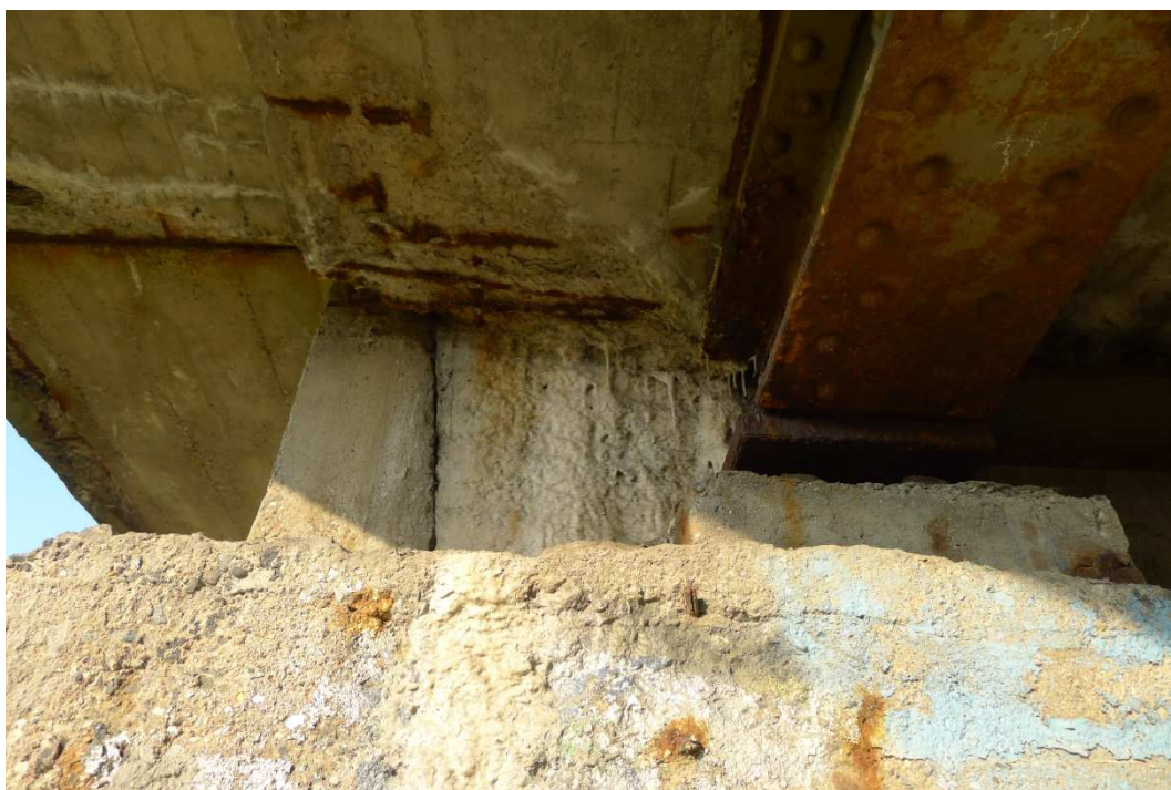
Fot. 20. Ubytki betonu płyty pomostowej przy podporze nr 1. Intensywne nacieki z węglanu wapnia.
