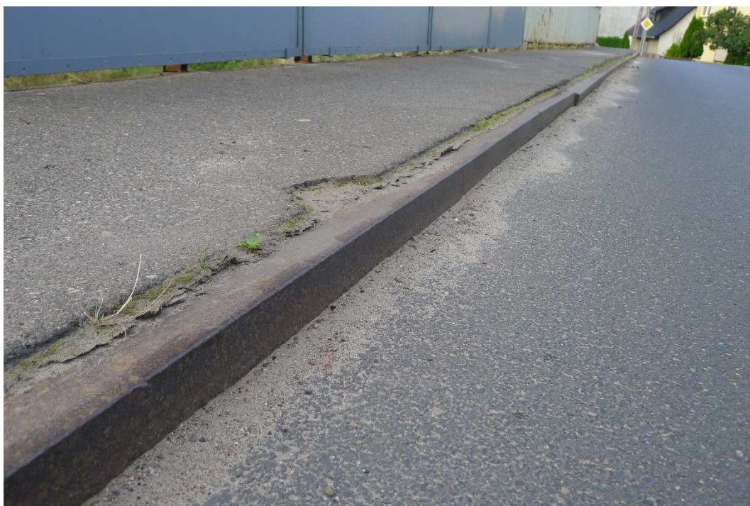
Fot. 8. Ubytek nawierzchni przy kątowniku zabezpieczającym krawędź wspornika. Wegetacja roślinna.
