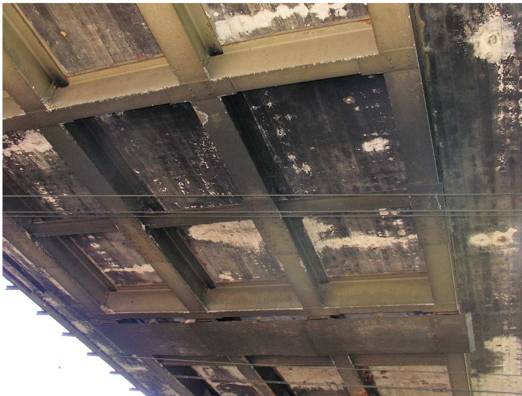
Fot. 9. Zanieczyszczenia ustroju nośnego pochodzące od spalin pojazdów szynowych. Nacieki spowodowane przesączeniem się wody przez płytę pomostu.
