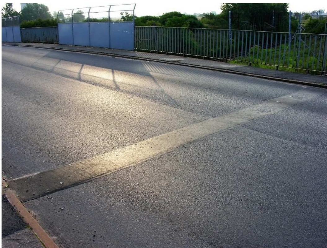
Fot. 1. Widok nawierzchni na obiekcie. Widok na dylatację na jezdni.
