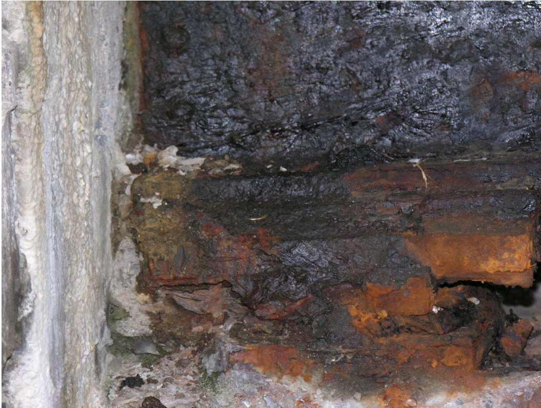
Fot. 17. Korozja łożyska.
